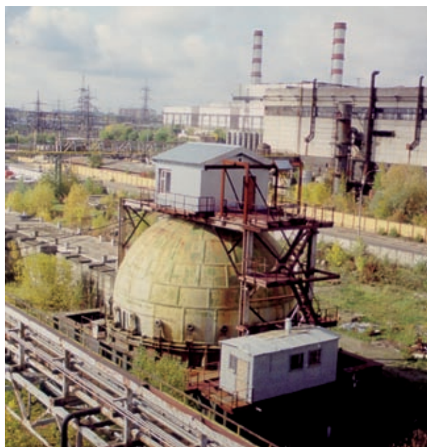
Сферическая камера 13Y3 объемом 900 м 3
